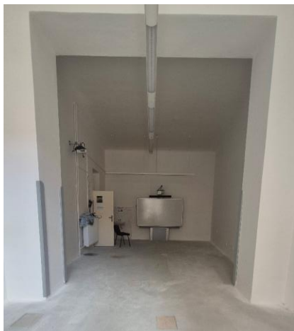
Stavební opravy v PC učebně
