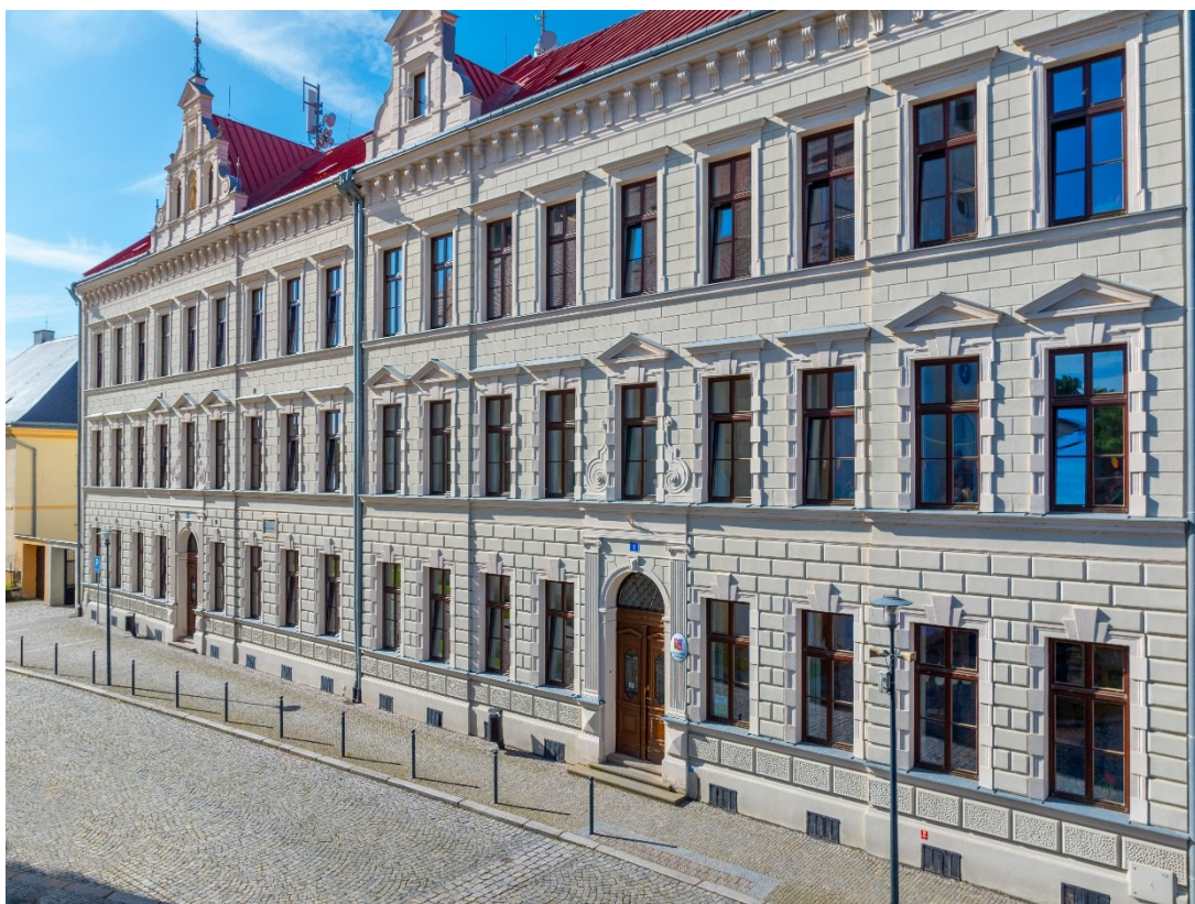
Budovy základní školy v ulici Förchtgottově v roce 2024
