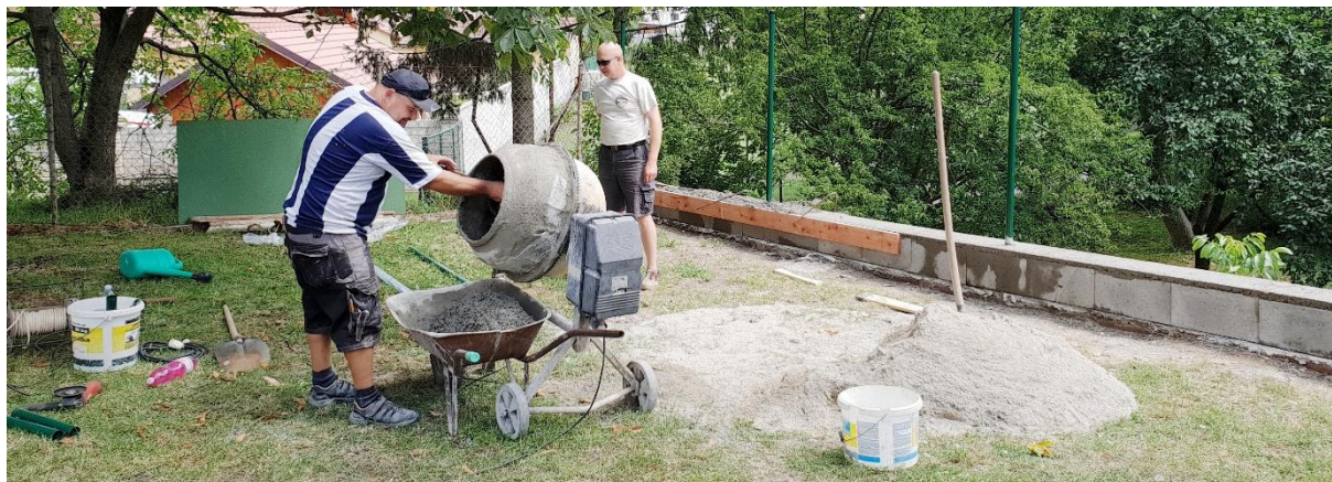
Oprava oplocení na zahradě mateřské školy
